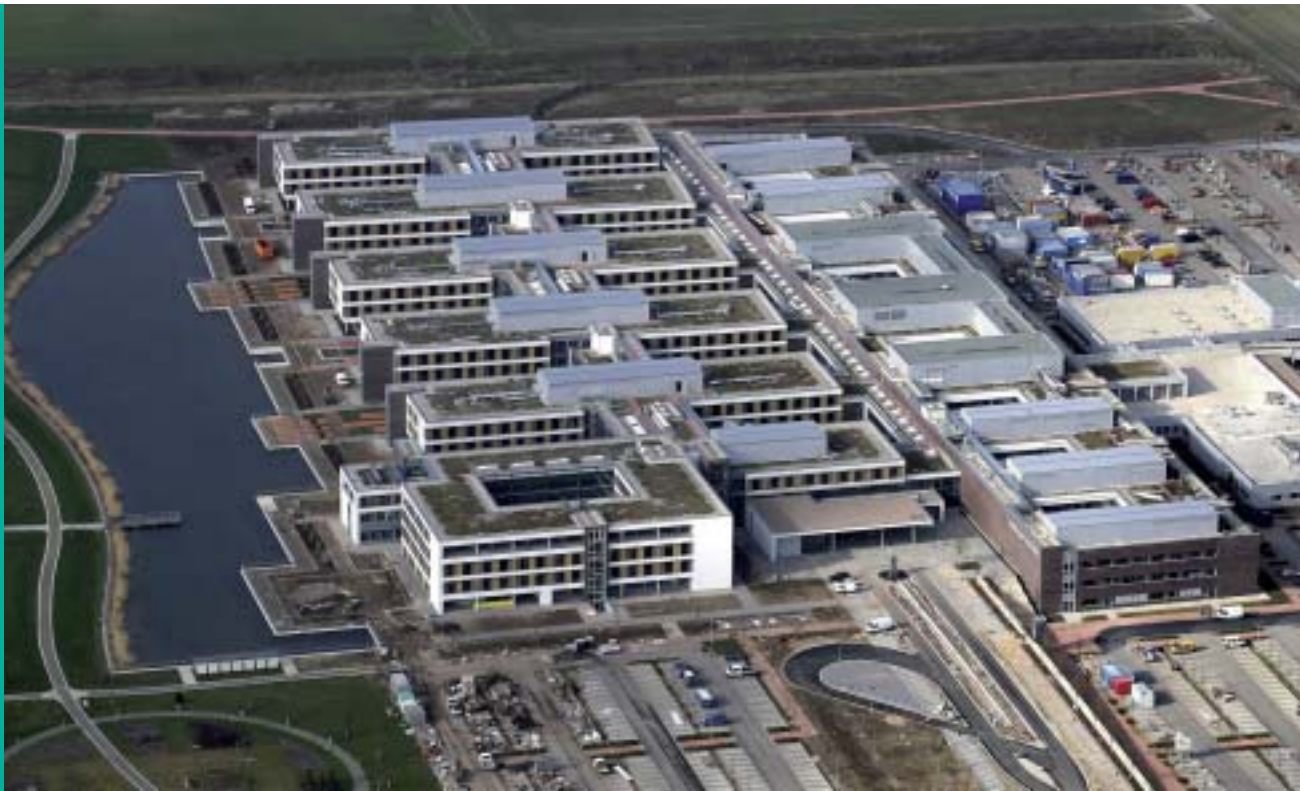
Neubau des Johannes Wesling Klinikums in Minden
