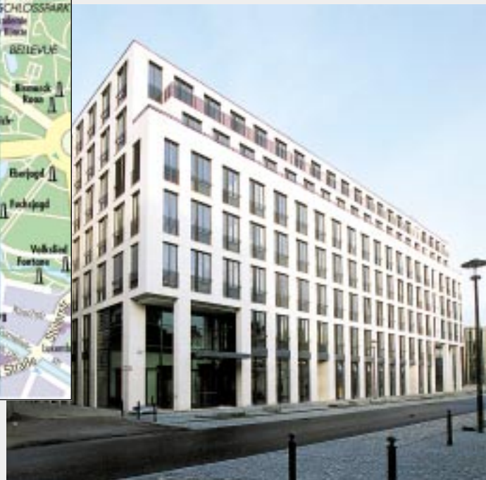
Das neue DKG-Gebäude in Berlin-Charlottenburg
